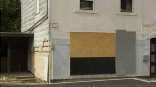
Die Schäden an den Gebäuden sind noch deutlich zu erkennen.
